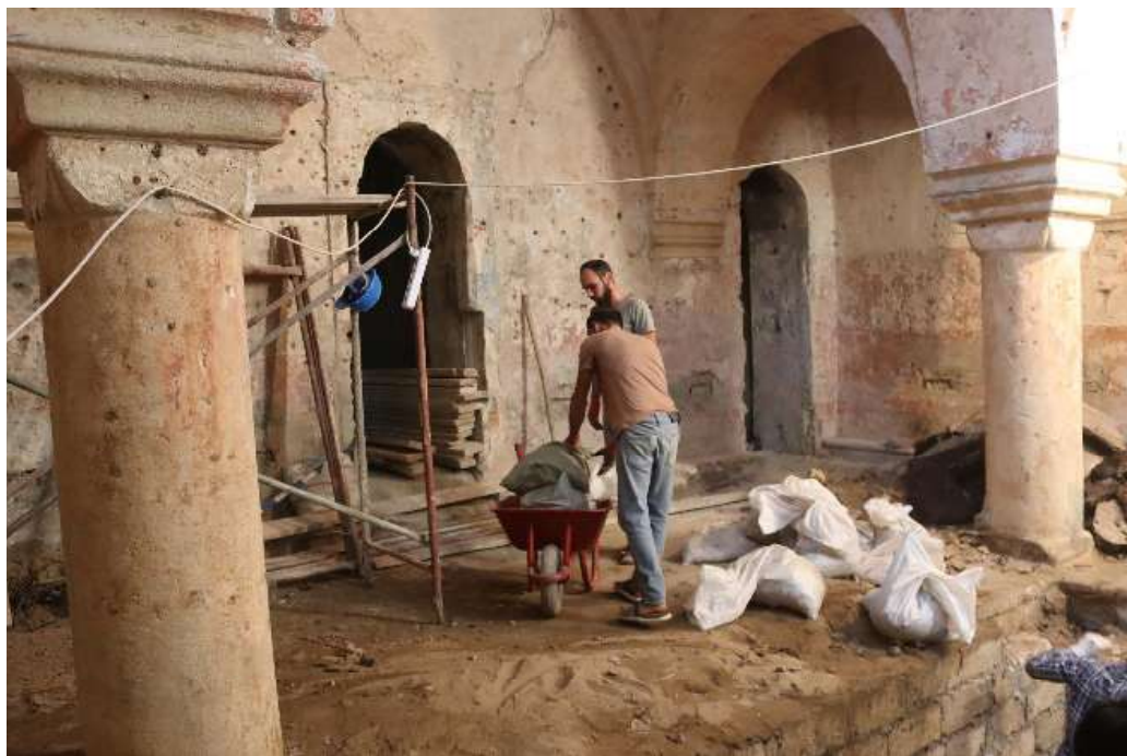
İkinci zalda istilik sistemi kanallarının təmizlənməsi
