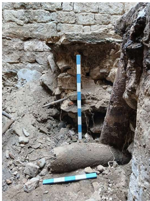
Dama çıxış pilləkəninin yerinə doldurulmuş qalıqların təmizlənməsi
