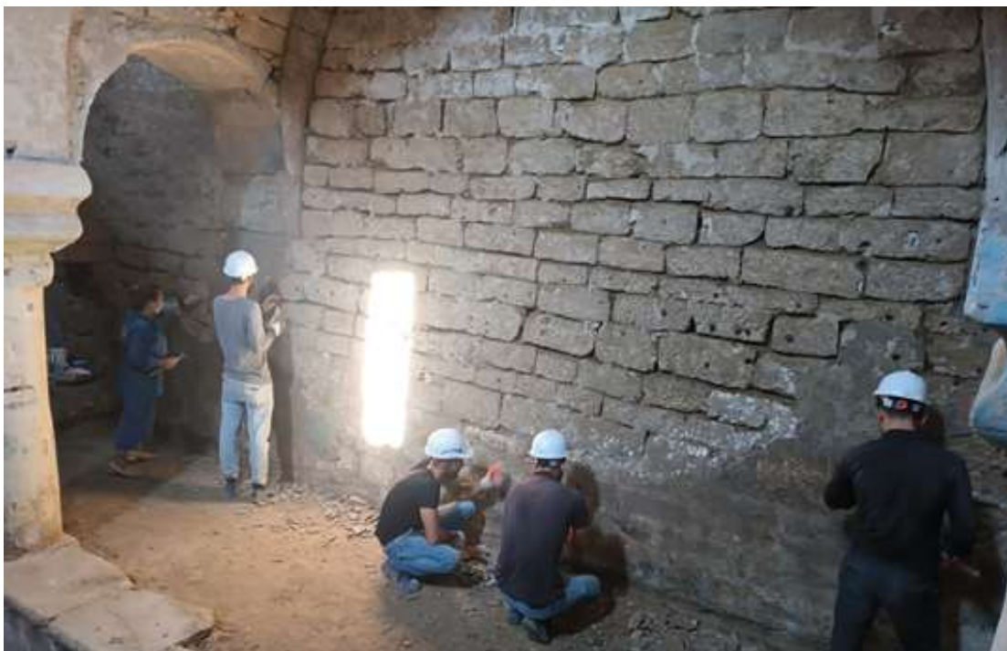
Birinci zalda sementli suvaqların təmizlənməsi
